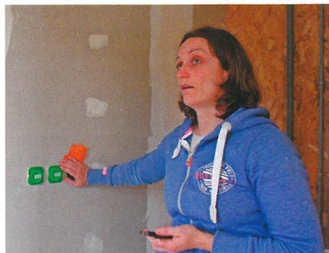
A 50 pa les fuites se ressentent à la main. Ici, en cause, la cage d'escalier qui n'est pas finie.
